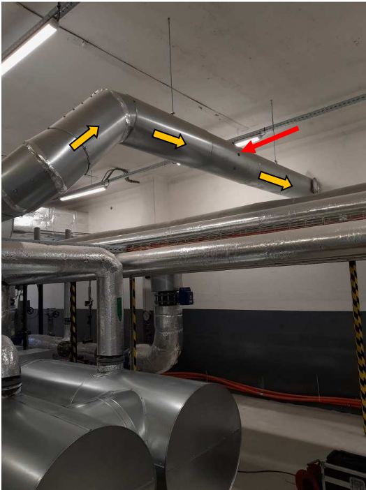
▲ Obrázok č. 1 Kogeneračná jednotka (KGJ) - vyznačenie meracieho miesta ← a smer prúdenia spalín ←
