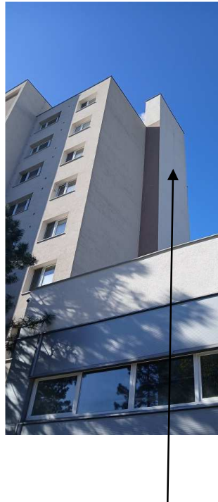
▲ Obrázok č. 2 Komín so samostatným priechodom – odvedenie spalín z KGJ
