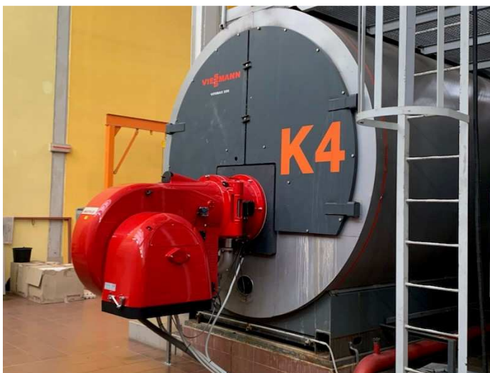
▲ Obrázok č. 3 Označenie kotla K4 (predmet OTČ) s novým horákom
